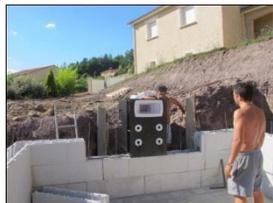
Poser le mur filtrant sur la dalle béton ou directement sur une ou plusieurs rangées de bloc polystyrène.
