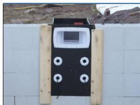
Positionnement et fixation des coffrages de chaque cotés, devant et derrière le mur filtrant pour assurer le maintien pendant le coulage.
