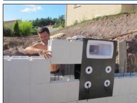
Monter la structure de bloc polystyrène de part et d'autres du mur filtrant.
