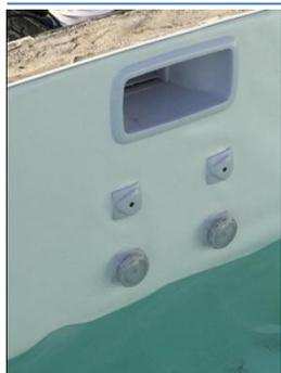
Bride d'étanchéité skimmer, buses et projecteur comme Traditionnellement pour la mise en place du liner ou du PVC armé.
